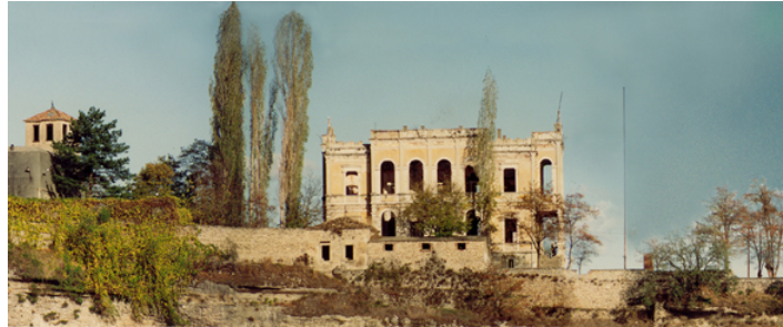
Safranbolu Eski Hükümet Konağı / Safranbolu Old Town Hall
